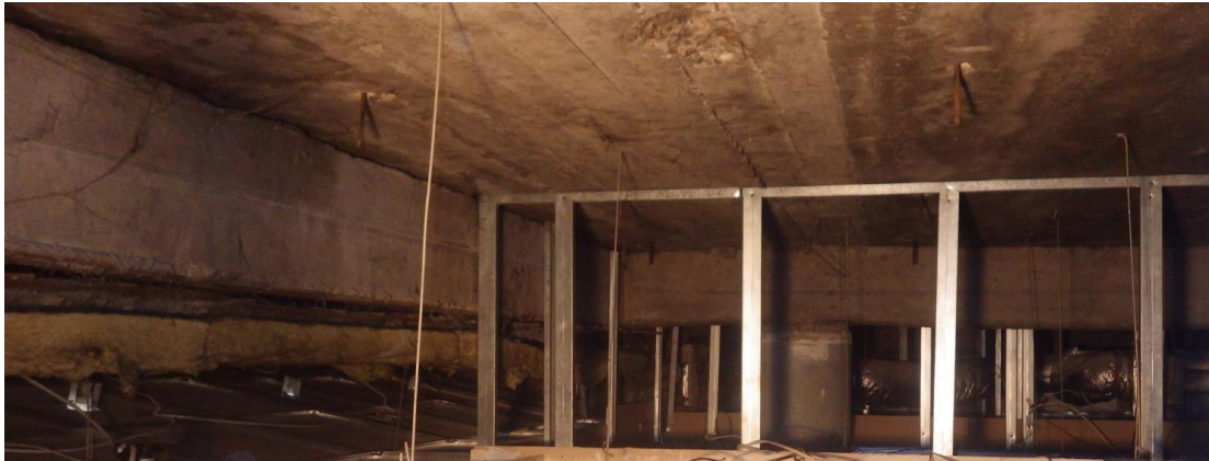
18 paveikslas. Surenkamos – monolitinės gelžbetoninės pirmojo aukšto perdangos tarp ašių 10 – 11 ir L – K vaizdas
