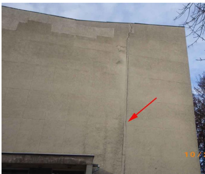
3 paveikslas. Plyšiai laikančiojoje mūro sienoje pastato ašyje A
