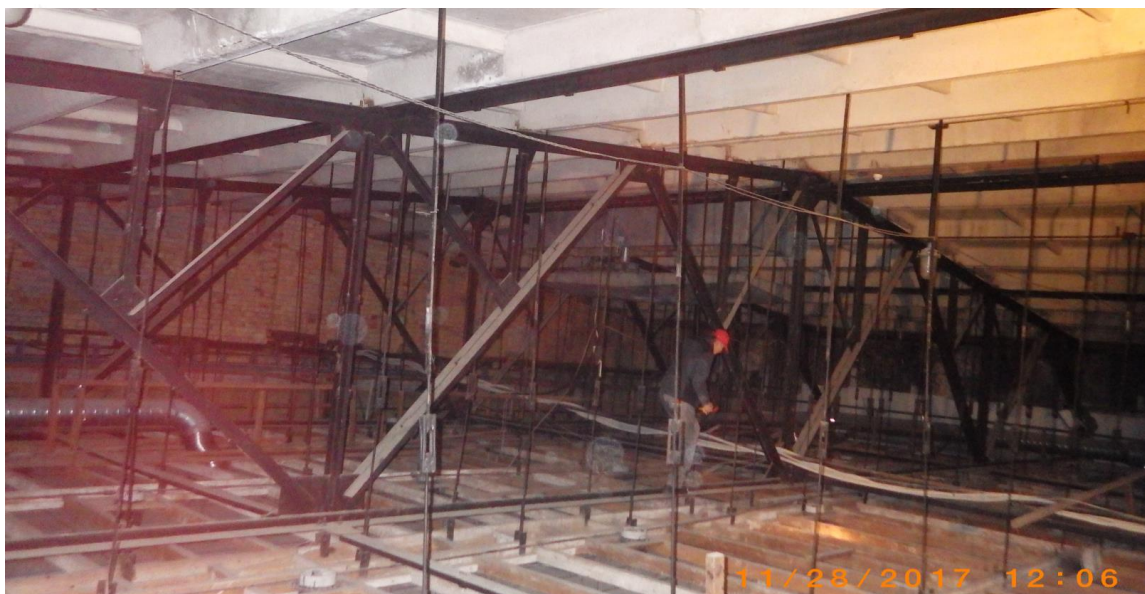
9 paveikslas. Plieninių santvarų konstrukcinė schema ir vaizdas
