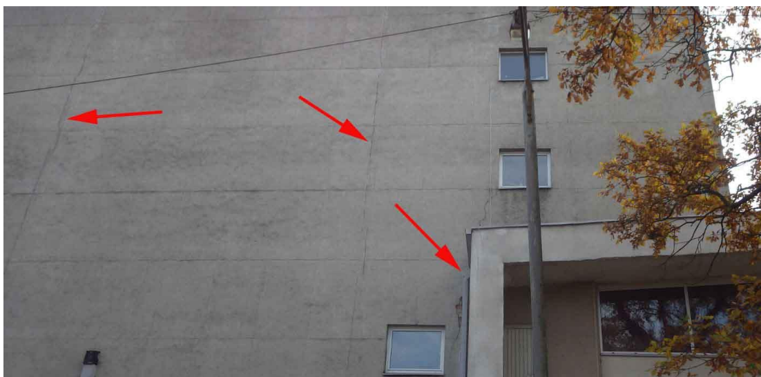
3 paveikslas. Plyšiai laikančiojoje mūro sienoje pastato ašyje A
