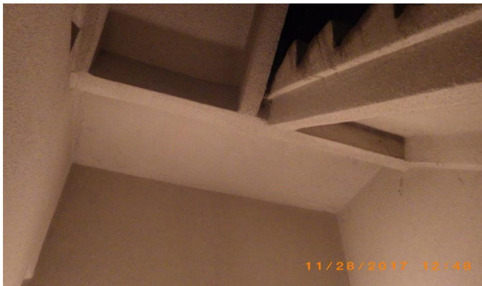
16 paveikslas. Laiptinės tarp pastato ašių M –E ir 10 – 11 laiptų konstrukcijos fragmentas
