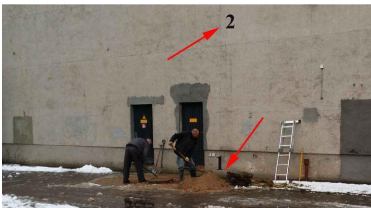
6 paveikslas. Pamatų atodanga (1) po mūro sienoje susiformavusiu plyšiu (2)
