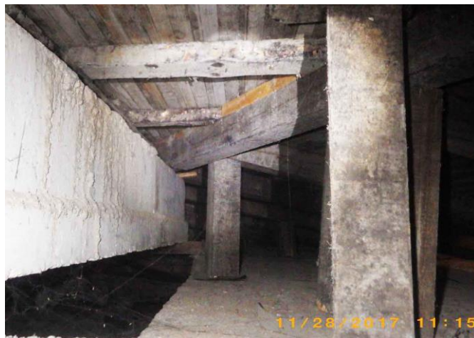
20 paveikslas. Medinės tribūnų konstrukcijos vaizdas
