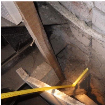
10 paveikslas. Plieninės santvaros atraminio mazgo vaizdas
