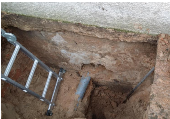
7 paveikslas. Surenkamų juostinių pamatų konstrukcija ir vaizdas kasinyje
