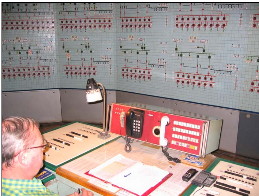
Paveikslėlis 3.2. Pastočių kontrolės centras, esantis 5-oje pastotyje
